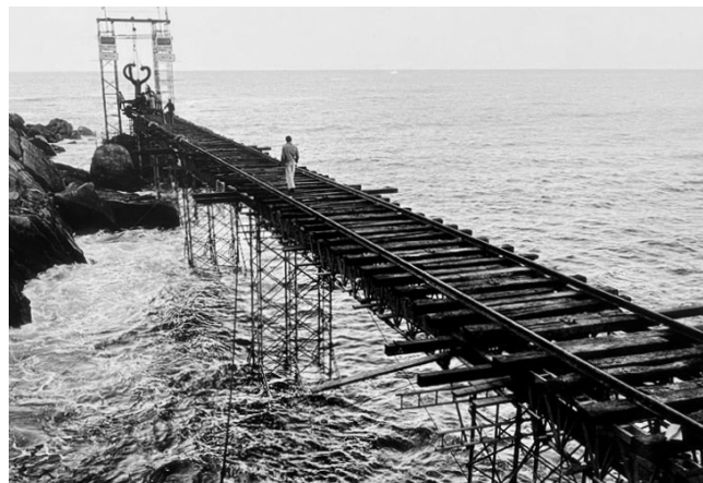
Fig.38. Eduardo Chillida, El Peine del Viento, c.1977. Fotografia dell'opera in costruzione.
